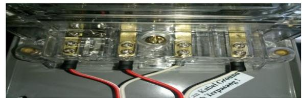
Gambar 9. Pemasangan Kabel IN dan OUT Pada KWH Meter
