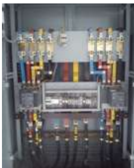
Gambar 3.13 ATS Tampak Bagian Dalam
