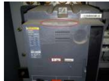
Gambar 3.14 Sensor pada Box PLN
