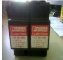
Gambar 2.2 Arrester dengan celah udara
