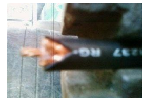
Gambar 3.2 Cara mengupas lapisan luar kabel coaxial
