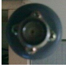
Gambar 3.5 Pemasangan konektor ke tutup pipa PVC
